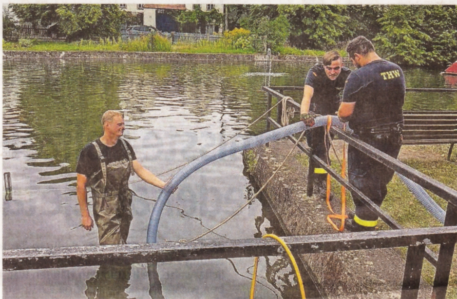
Die Helfer des THW Radebeul installieren Umwälzpumpen am Naundorfer Dorfteich. Kleine Springbrunnen im Teich sollen zudem helfen, das brackige Wasser wieder mit Sauerstoff anzureichern.
